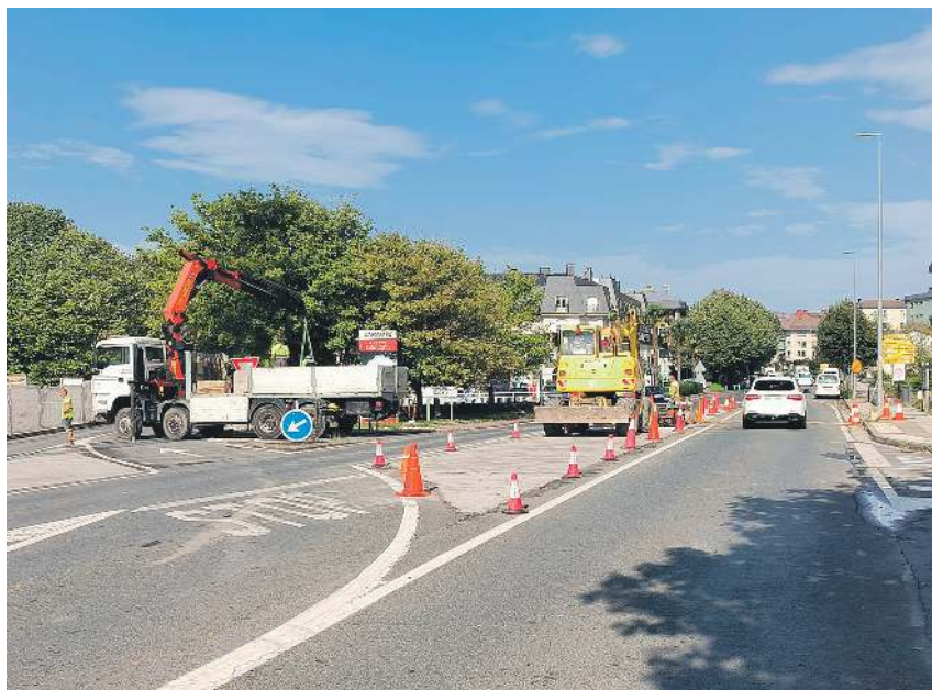
Gipuzkoa eta Nafarroa kaleak elkartzen diren puntuan, lanean. ZARAUZKO UDALA
