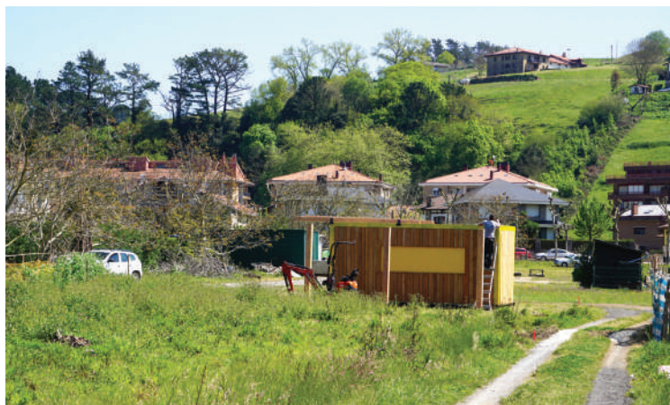
Paloten gunean materiala eta erramintak gordetzeko etxola jarri dute. IÑIGO GAITON
