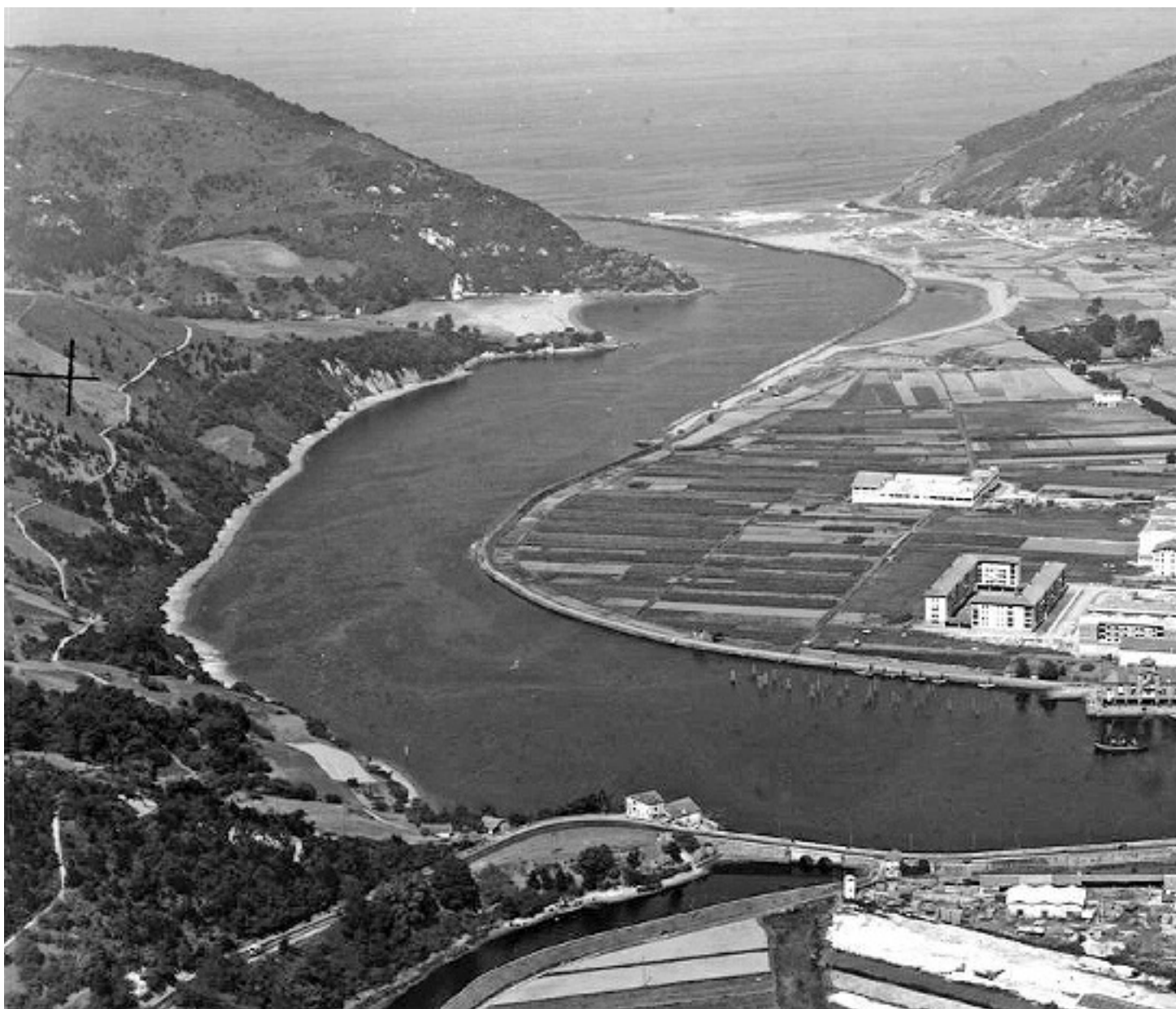
Errioak lotzen eta bereizten ditu Aia eta Orio, Oriak egiten ditu zubi-lanak. ORIOKO UDAL ARTXIBOA
