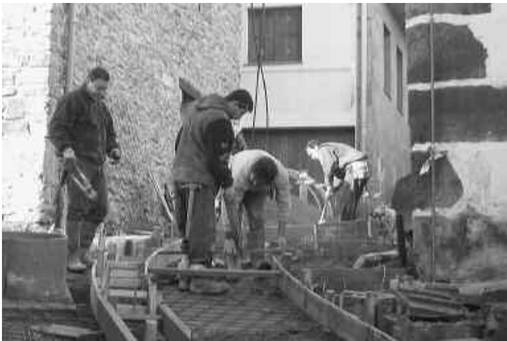
OBRAK MARTXAN. Kaleak eraberritzearekin batera gas hornidura sarea sartzten ari dira.
